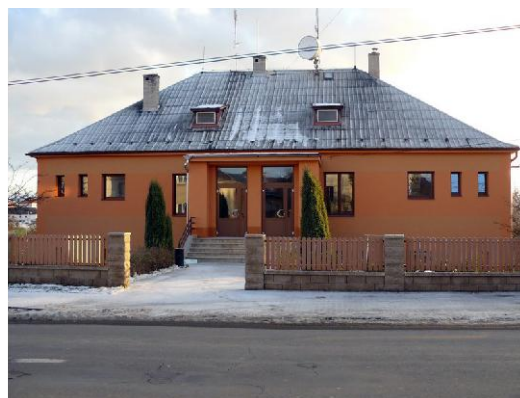
Obr. 11 a 12 – Budova před a po rekonstrukci (zdroj Energetická agentura)
